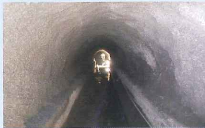
第二支線水路トンネル(吹付完了)
