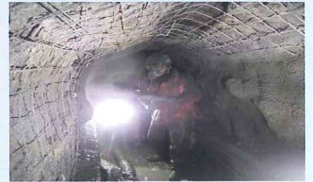
第二支線水路トンネル(吹付状況)
