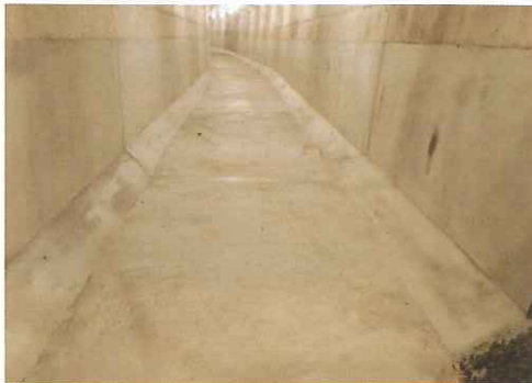
第一幹線表面被覆完成
