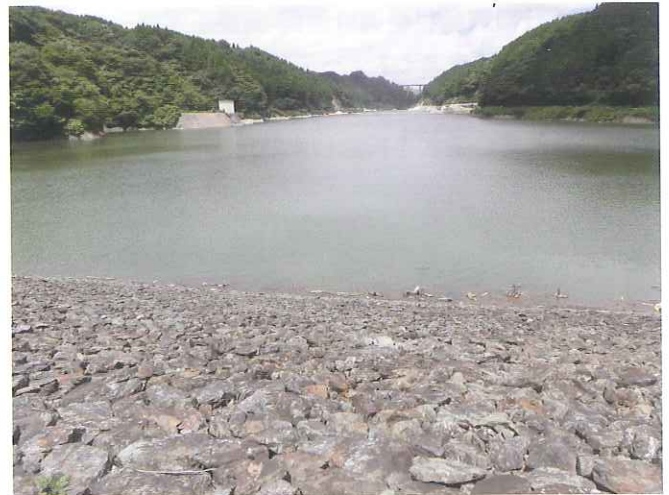
大蘇ダム天端よりダム貯水池を望む (H30.7.10撮影) 満水位 675.00mに到達
