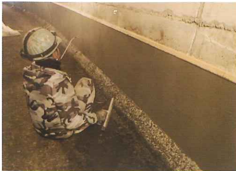
第一幹線表面被覆作業中
